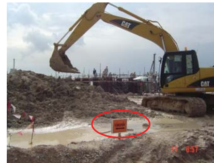
งานขุดระวังสายไฟใต้ดิน
